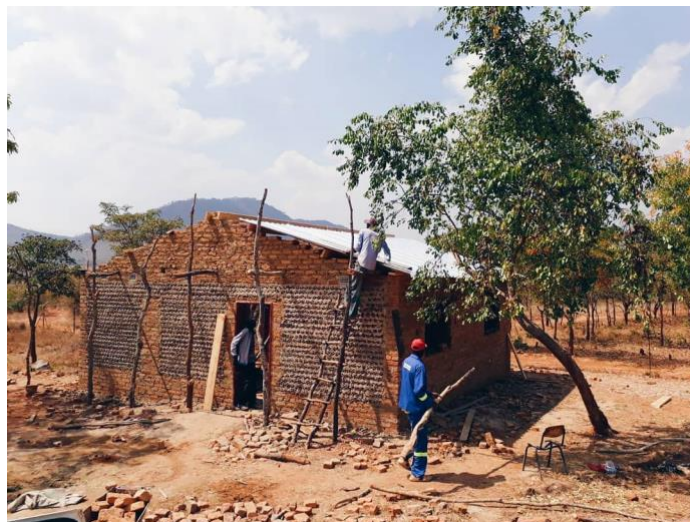
Figura 17: Construcción de un edificio con botellas de vidrio para el orfanato
