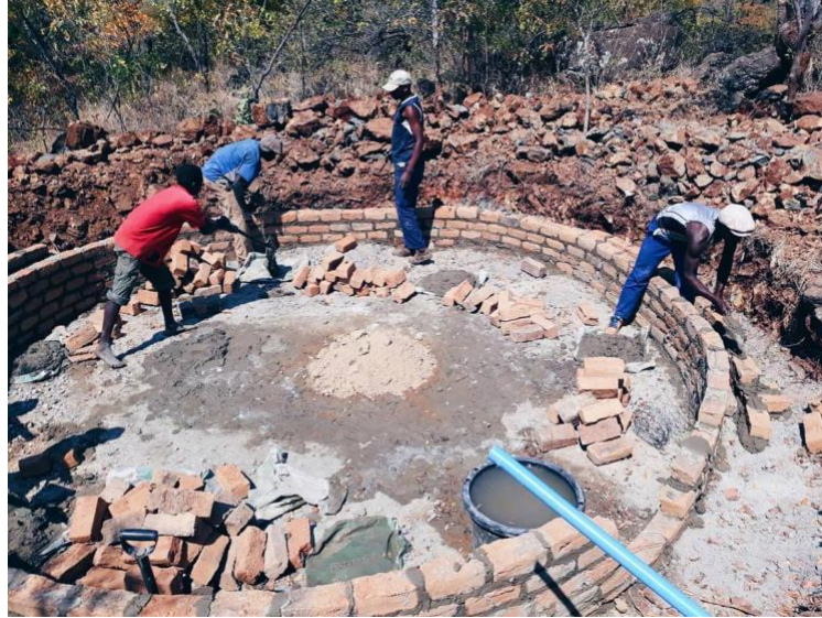
Figura 16: Tanque de agua para el riego de la plantación del orfanato CFA
