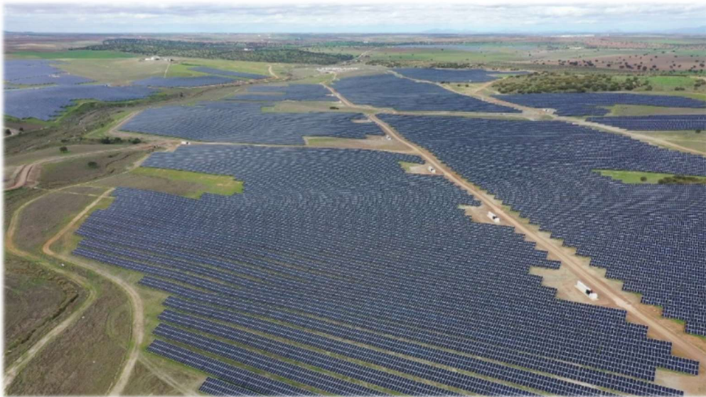
Figura 32. Planta fotovoltaica Núñez de Balboa [56].
