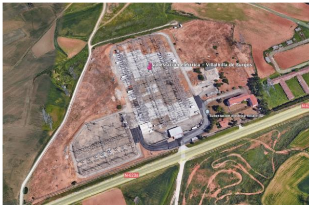
Figura 49 - Subestación eléctrica de Villalbilla de Burgos [GEP_21]
