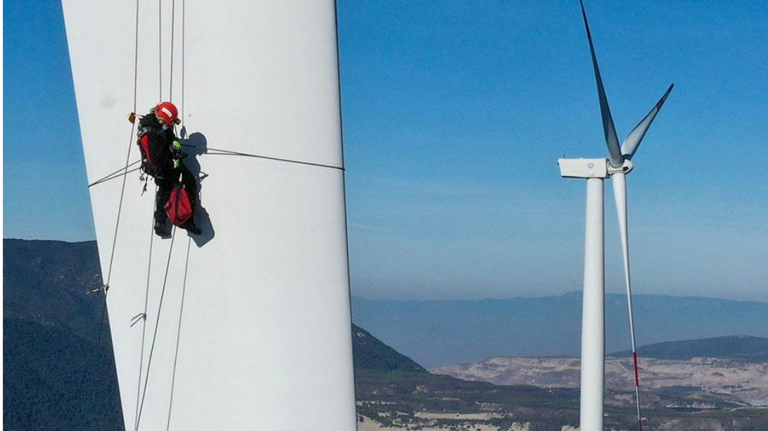
Figura 20: Inspección en altura
