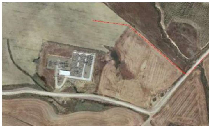
Ilustración 25 – Llegada a la subestación que necesita cambios
