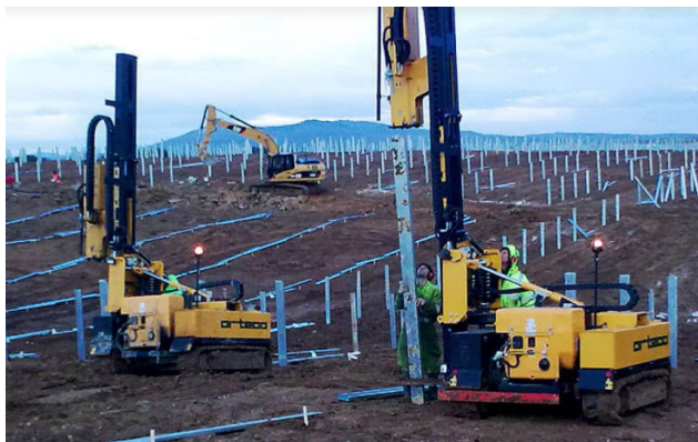
Figura 26. Hincadora necesaria para la instalación de los soportes.
