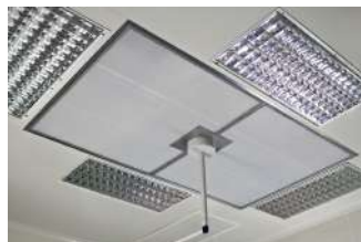
Techo FILTRANTE QUIROFANO Versión TEXTIL Mod. DSS
