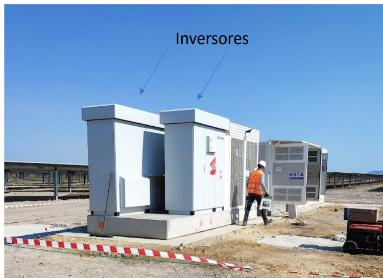
Figura 7: Isla de inversores de CC a CA
