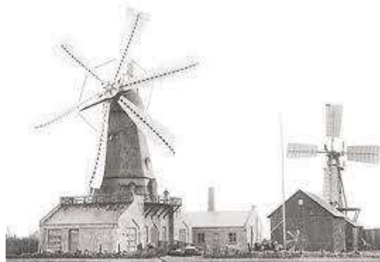
Figura 59: Aerogeneradores Lacour (F.Asia)
