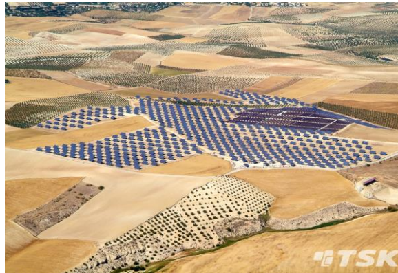
Ilustración 31: Planta fotovoltaica Las Gabias
