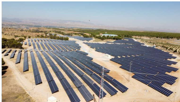
Ilustración 33: Planta Fotovoltaica Guadix
