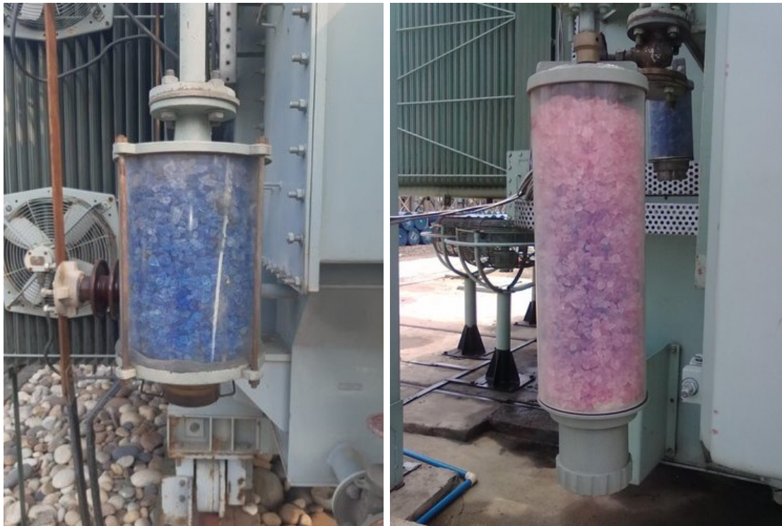
Figura 13: Aireadores convencionales de silica-gel.
