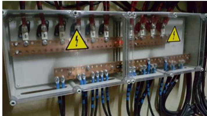
Ilustración 22 Protección circuitos continua
