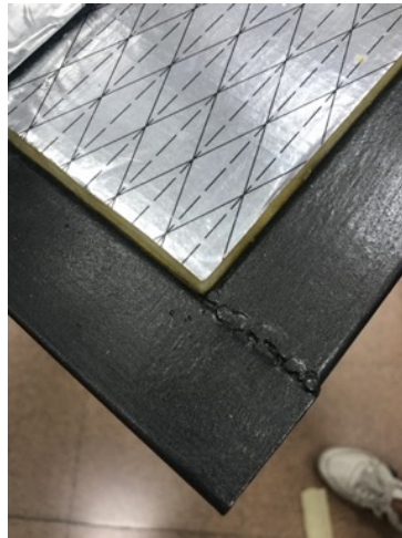
Ilustración 27: Acabado de la soldadura de los perfiles de acero.
