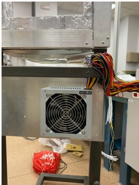
Ilustración 52: Instalación de fuente de alimentación ATX.
