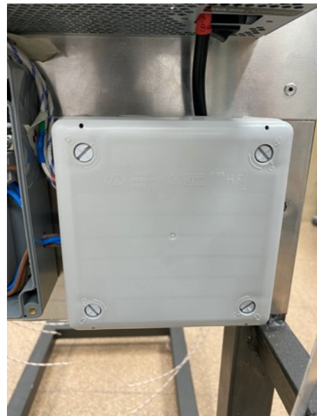
Ilustración 53: Instalación de cajetín de alimentación.
