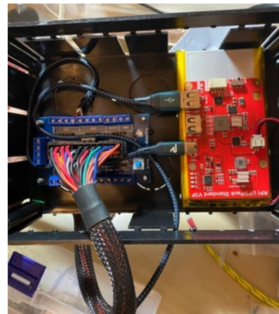
Ilustración 70: Instalación final del cajetín UPS.
