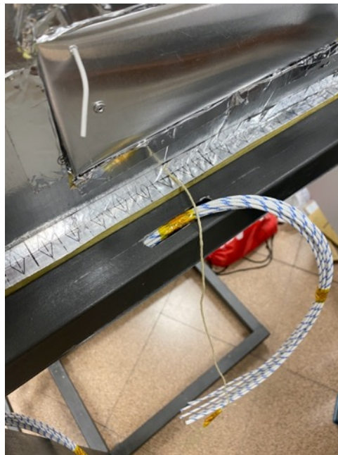
Ilustración 49: Canalización del cableado por el interior de la perfilaría.
