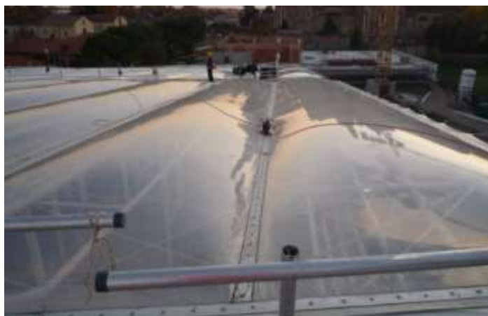
Imagen 21: Cubierta de EFTE en el Jardín Botánico de Padua (Vimercati, n.d.)
