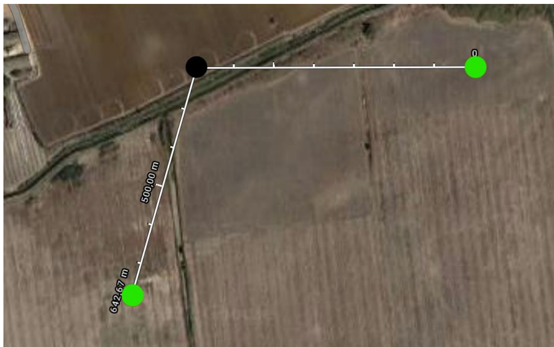
Ilustración 19: Metros de cableado de media tensión (Fuente: Google Maps 2022)
