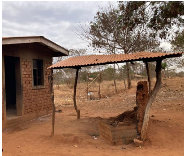
Ilustración 7: Cocina de una casa de Nyumbani Village.
