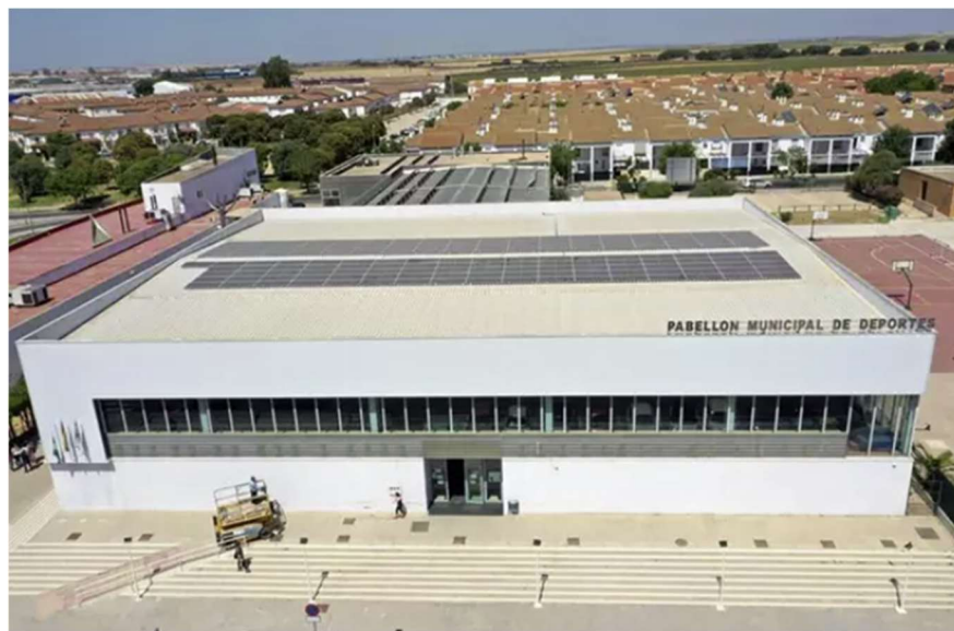
Figura 4.2: Instalación de la planta fotovoltaica de la Fundación Acciona en San Juan del Puerto Fuente: (Europapress, 2022)
