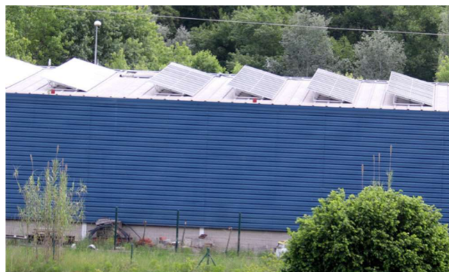
Figura 4.3: : Instalación de la planta fotovoltaica del municipio de Celler del Ter Fuente: (El Punt Avui, 2021)
