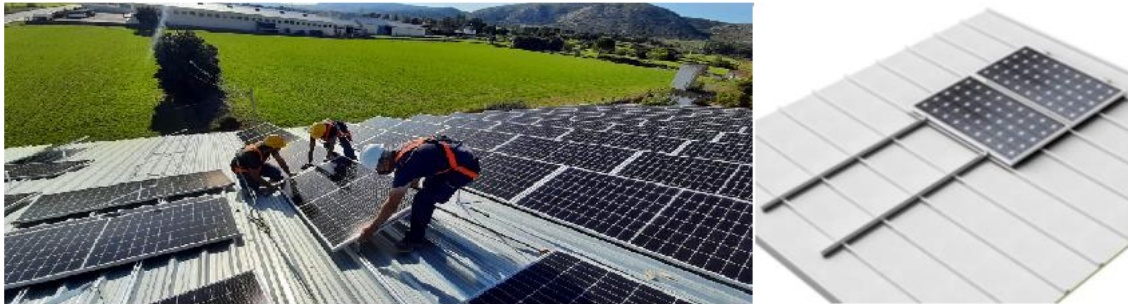
Figura 16. Estructura elevada y estructura coplanar (seguí, efectoled)
