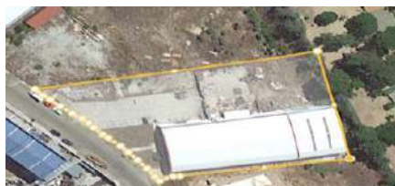
Superficie y naves originales de partida de este proyecto.
