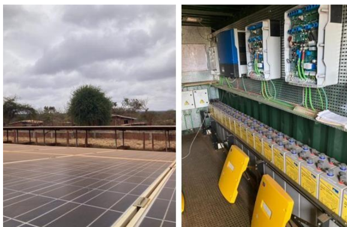
Fotografía 12. Instalación del huerto solar. Elaboración propia.
