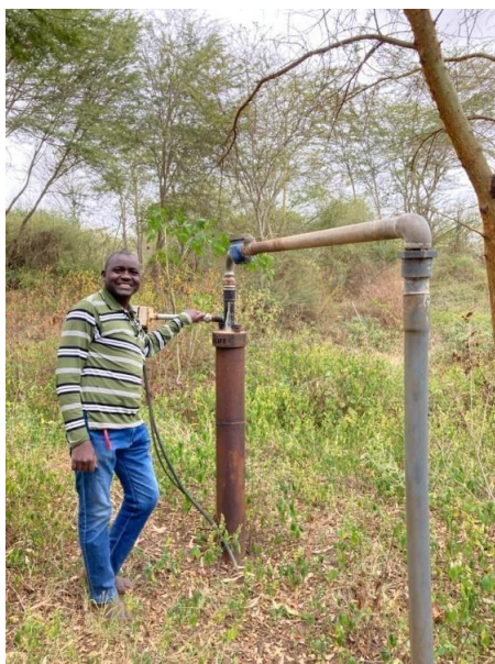
Fotografía 11. Bomba de un pozo profundo. Elaboración propia
