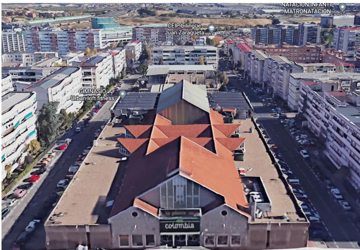
Ilustración 10. Cara oeste del edificio
