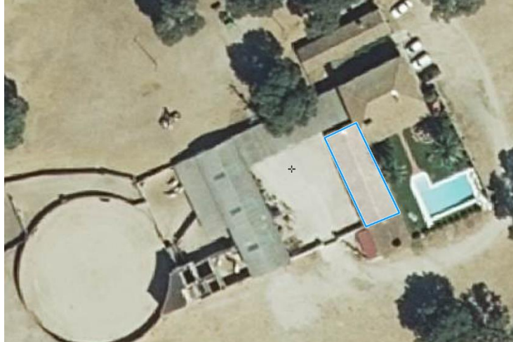
Figura 5.5: Tejado del guadarnés.
