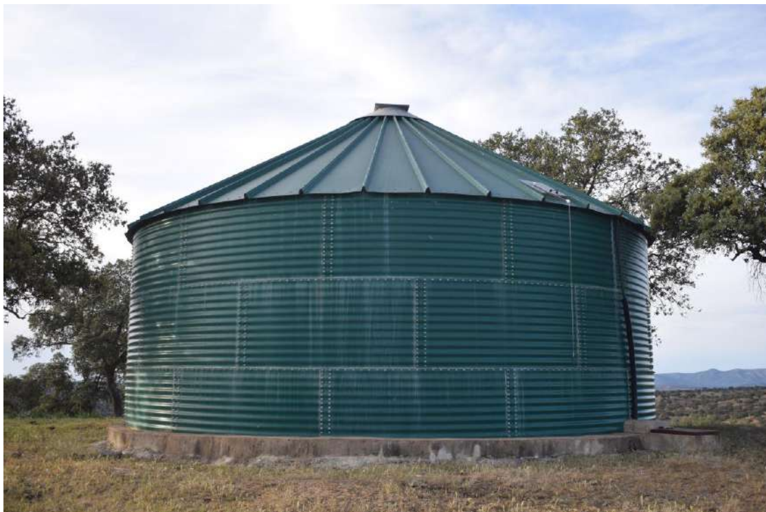
Ilustración 4.9: Exterior del depósito de chapa cerrado [elaboración propia]
