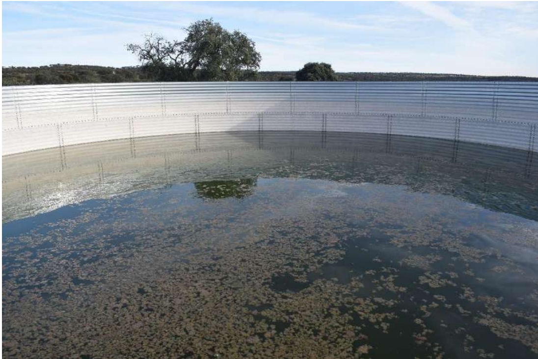
Ilustración 4.8: Interior del depósito de chapa abierto [elaboración propia]
