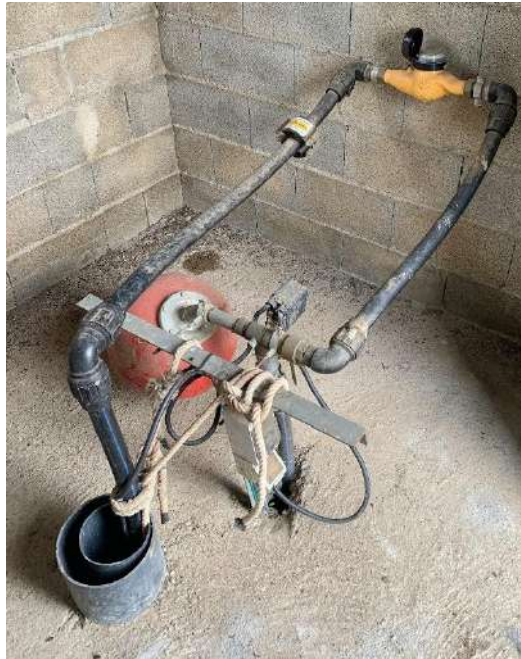
Ilustración 4.1: Sondeo con bomba y contador [elaboración propia]
