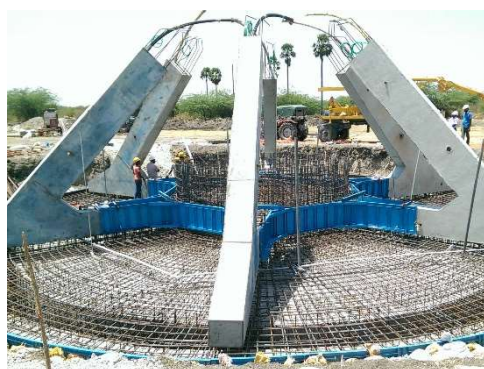
Ilustración 31: Cimentación de Jabalcones
