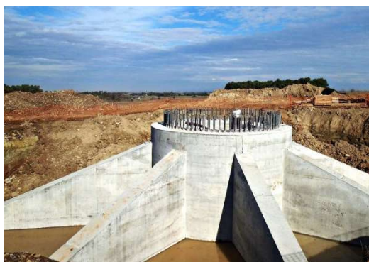
Ilustración 32: Cimentación de contrafuertes
