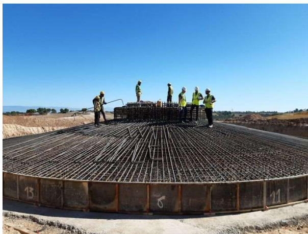
Ilustración 27: Cimentación anular
