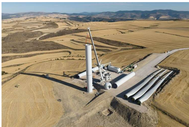
Ilustración 25: Plataforma de montaje
