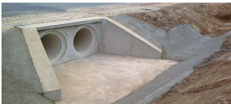
Ilustración 24: Drenaje de un parque eólico
