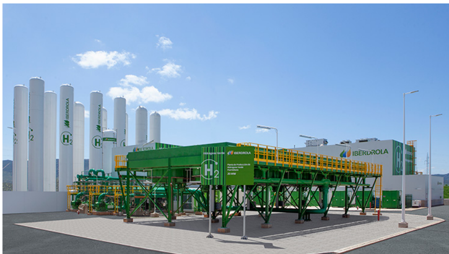
Planta de Iberdrola en Puertollano, Ciudad Real (España)
