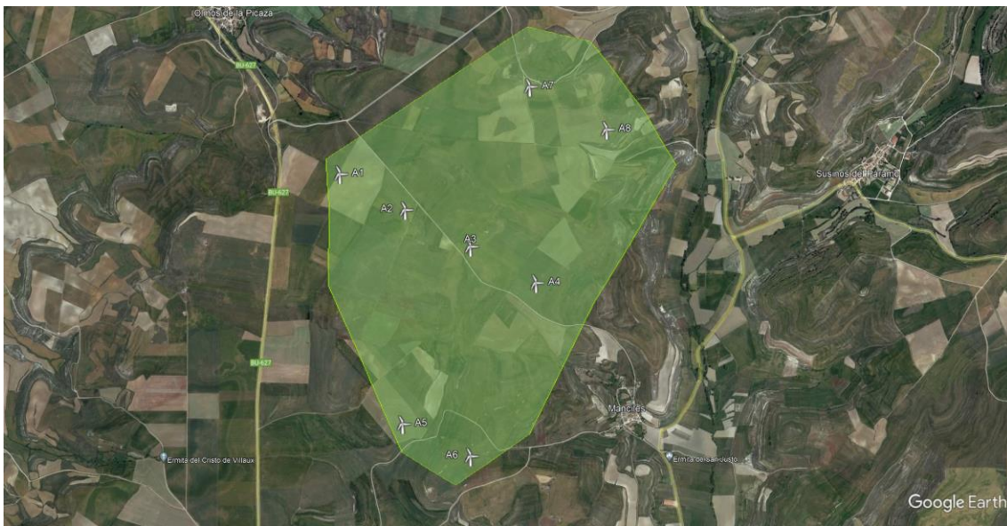
Figura 2. Disposición de los aerogeneradores en el emplazamiento con vista al norte. -Fuente: Google Earth Pro
