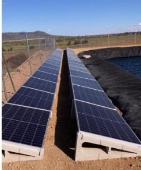
Figura 48: Placas solares sobre tierra (Fuente: Elaboración propia, 2021)
