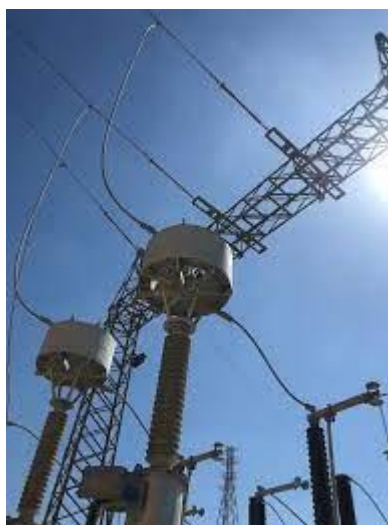
Figura 62: Bobina de bloqueo [25]
