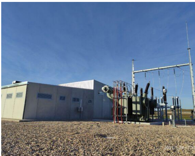
Figura 74: Edificio de control
