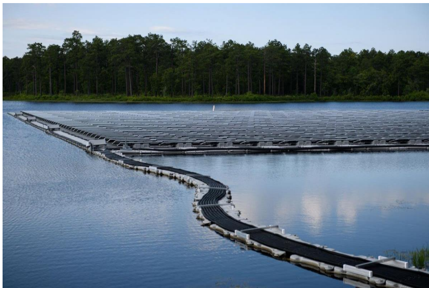
Ilustración 38 - Estructura de flotación cable [62]
