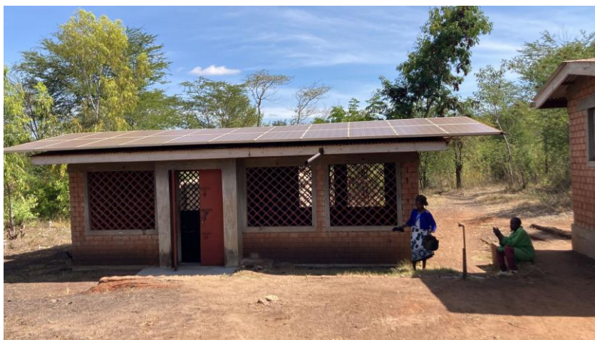
Figura 11. Placas solares. Generación solar de la bomba
