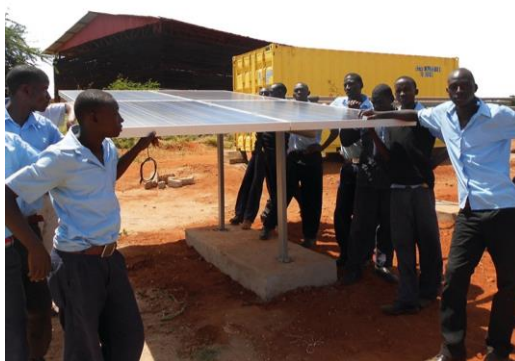
Figura 2. Instalación de un sistema minigríd eléctrico en Nyumbani (Kenia)
