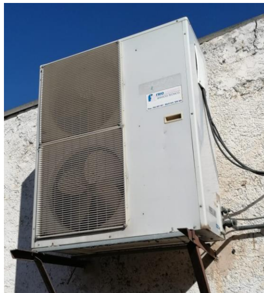
Figura 32. Motor refrigerador del tanque de 1.200 L
