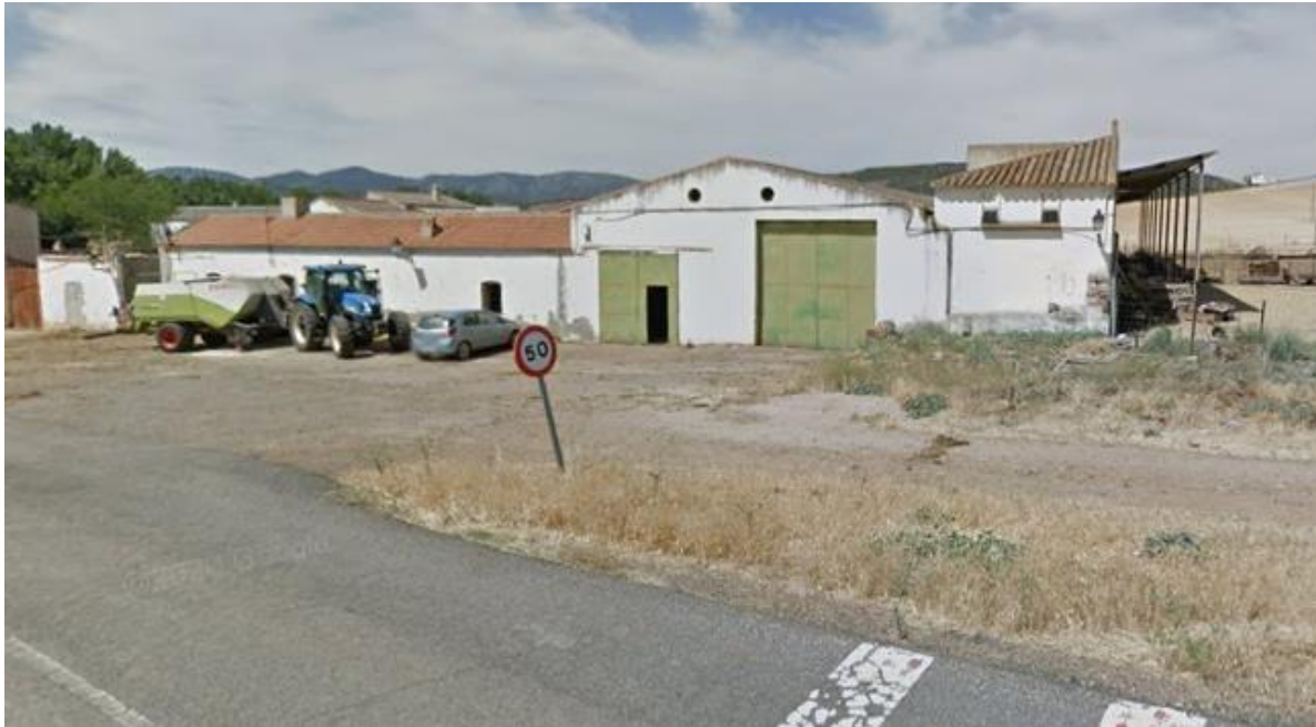
Figura 18. Vista frontal de la nave industrial en La Alameda
