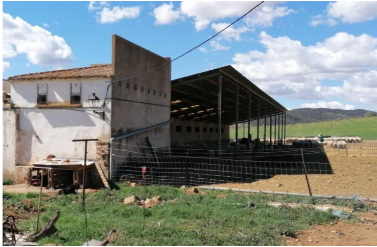
Figura 19. Cubierta de la instalación
