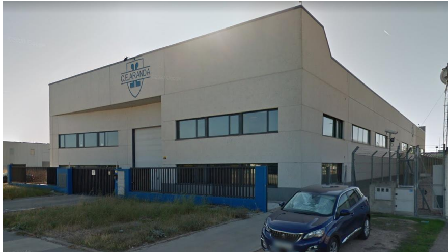
Figura 18. Fachada de la nave
