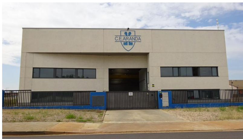
Figura 19. Fachada del edificio
