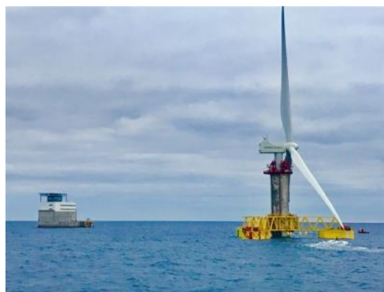
Figura 10: Primer aerogenerador marino en España [38].
