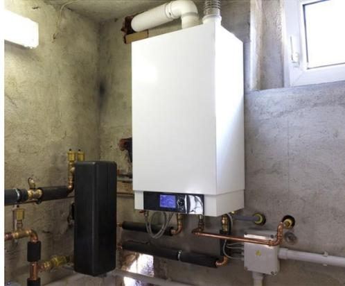
*Ilustración 9: Caldera de condensación*
