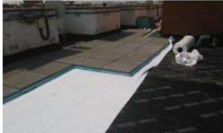
*Ilustración 7: Aislante en cubiertas*
