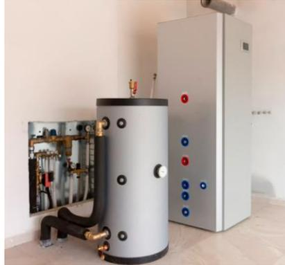
*Ilustración 15: Sistema de geotermia*
