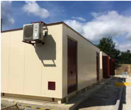
Módulo tipo CIAT de estructura metálica
