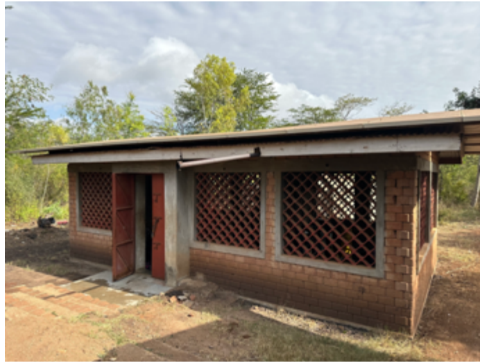
Ilustración 13 Construcción de la booster pump
