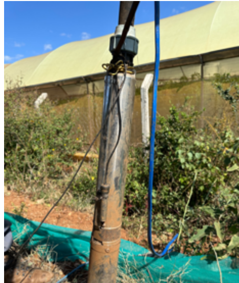
Ilustración 23 Bomba sumergible empleada en los embalses
