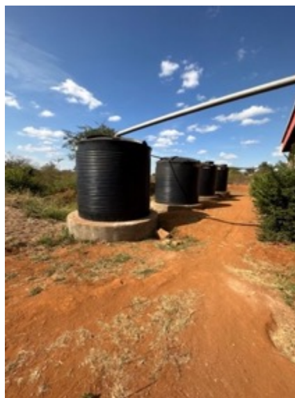
Ilustración 28 Tanques de Captación de la Iglesia
