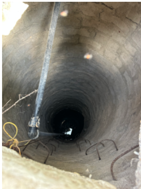
Ilustración 20 Pozo de Poca Profundidad
