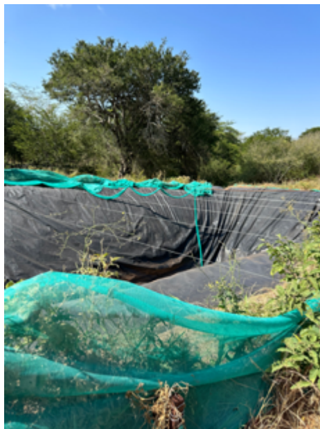
Ilustración 22 Balsa Plastificada en Uso
