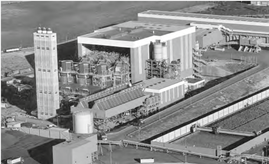
[Figura 3] Vista general de la planta de valorización
