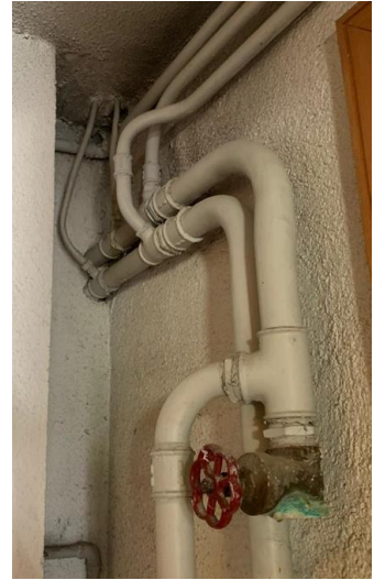
Ilustración 141. Estado de las tuberías de cobre. Algunos puntos de la instalación presentan alto grado de corrosión. (Fuente: Elaboración propia)
