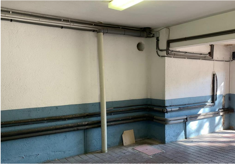
Ilustración 141. Estado de las tuberías de cobre. Algunos puntos de la instalación presentan alto grado de corrosión. (Fuente: Elaboración propia)
