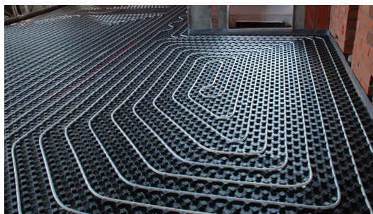
Ilustración 79. Suelo radiante GRAFLIPAC y bomba Grundfos Magna1. (Fuente: ESAK)
