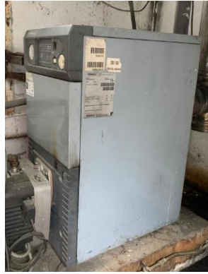
Ilustración 155. Caldera Ferroli GNI 05 (Fuente: Elaboración propia)
