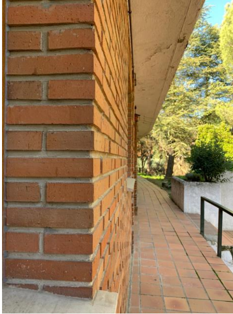
Ilustración 146. Paredes exteriores gruesas de ladrillo. (Fuente: Elaboración propia)
