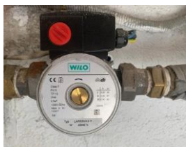
Ilustración 153. Bomba Wilo LARS 25/6 (Fuente: Elaboración propia)
