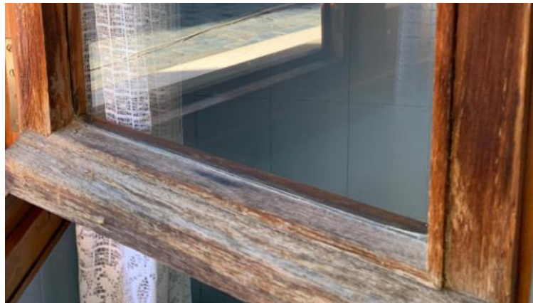
Ilustración 144. Perfil de madera perjudicado. (Fuente: Elaboración propia)
