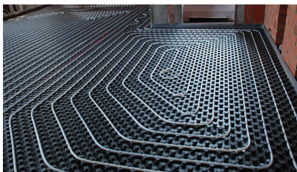
Ilustración 25. Suelo radiante GRAFLIPAC. (Fuente: ESAK)
