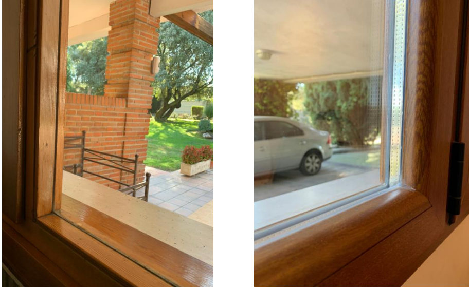
Ilustración 143. Comparativa de una ventana antigua con una nueva. (Fuente: Elaboración propia)
