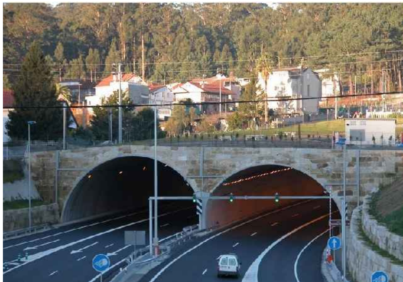
Figura 13: Vista túnel boca este
