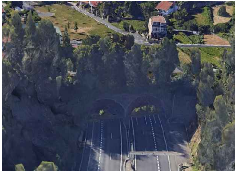
Figura 14: Vista túnel boca oeste
