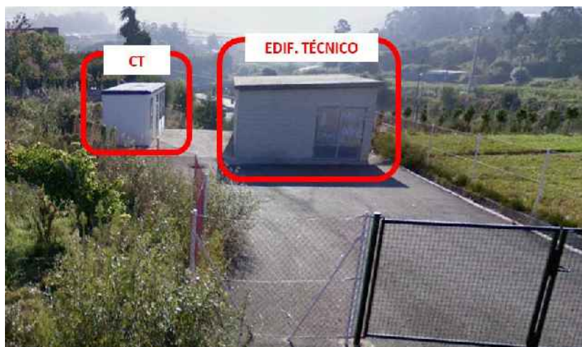
Figura 17: Exterior centro de transformación y control túnel
