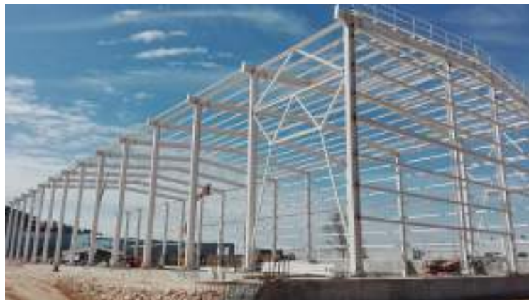
Figura 22: Nave industrial de estructura metálica
