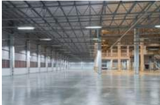
Figura 24: Nave industrial con estructura mixta
