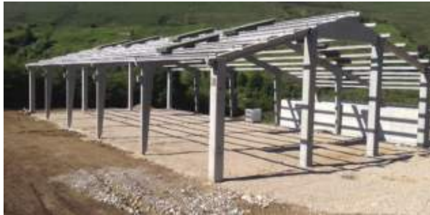
Figura 23: Nave industrial con estructura de hormigón prefabricado
