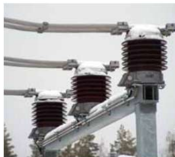
➤ Ensayo de tipo. CG 245 kV. ➤ Transformadores de intensidad de 36 kV. Fingrid, Kirmy (Finlandia).
