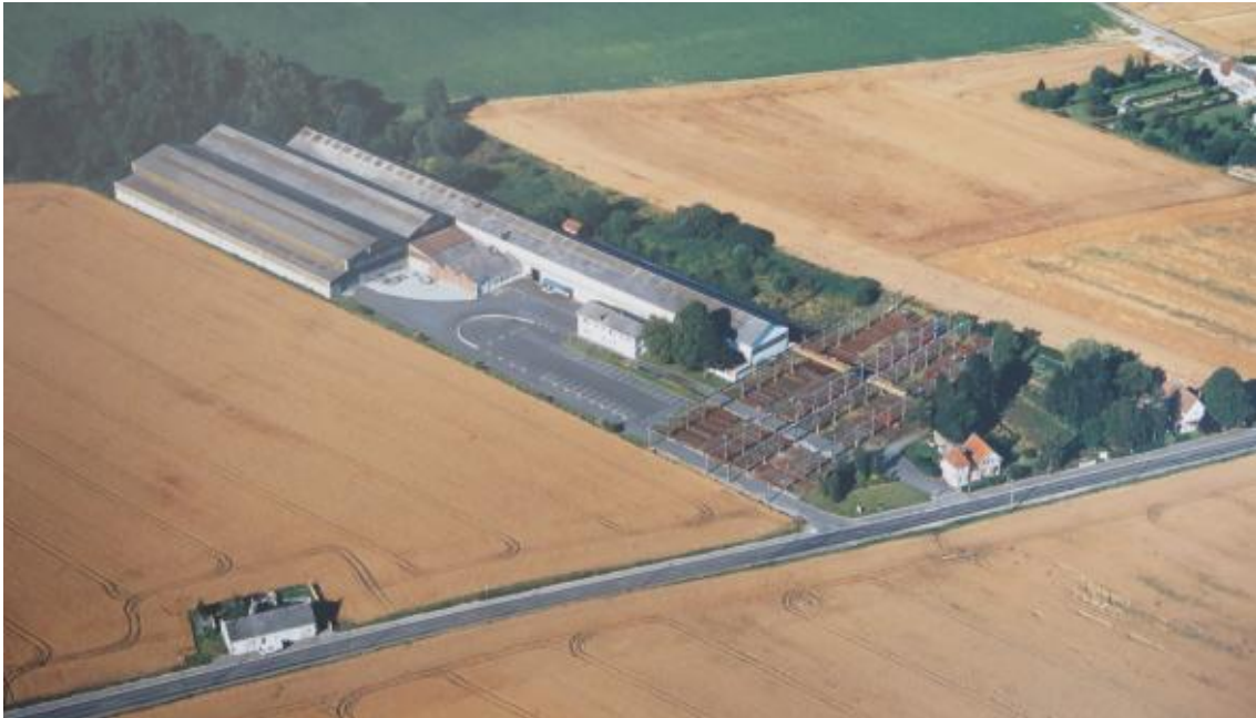
Figura 1: Vista de pájaro de la fábrica.
