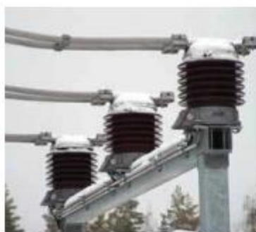
Ensayo de tipo. CG 245 kV. Transformadores de intensidad de 36 kV. Fingrid, Kimy (Finlandia).
