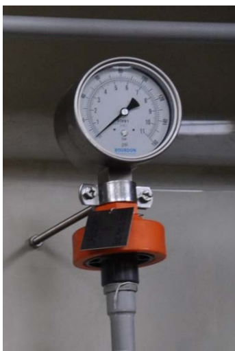
Figura 1-14. Manómetro con separador de membrana
