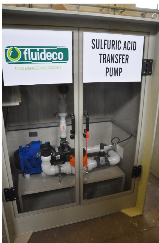
Figura 1-12. Armario para bombas de llenado
