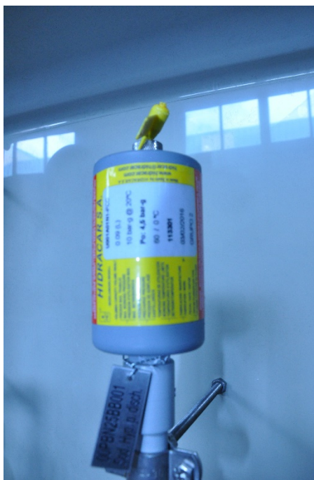
Figura 1-15. Amortiguador de pulsaciones
