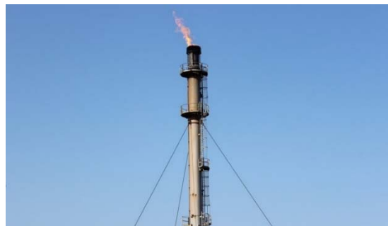
Figura 30. Antorcha. Cortesía de Petronor.
