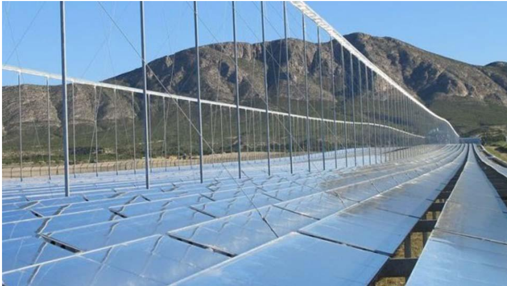
Imagen 1.7: Colector solar Fresnel lineal
