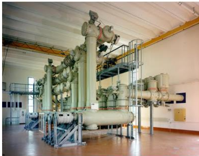
Ilustración 14. Aparataje GIS (ABB).
