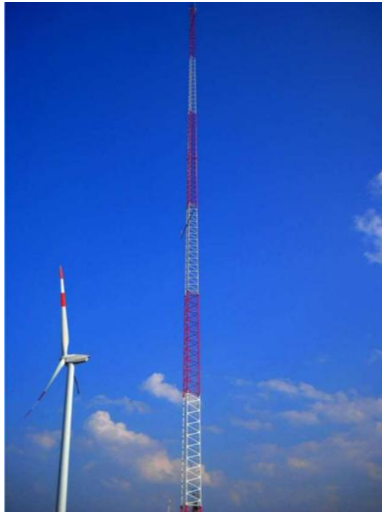
Figura 17. Torre anemométrica. Parque eólico Miravete. Elawan Energy [39]
