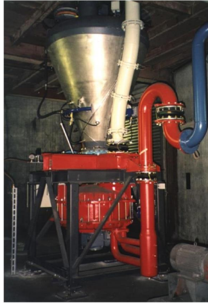
Figura 2: Báscula Dosificadora Pfister DRW [6]
