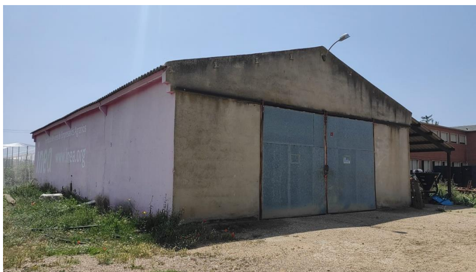
Ilustración 14: Vista de la nave de almacenamiento
